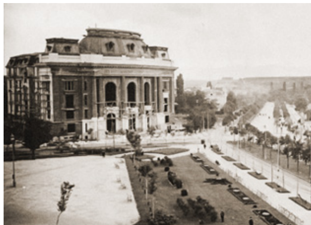
Софийският университет в строеж, сградата е завършена през 1934 г.
